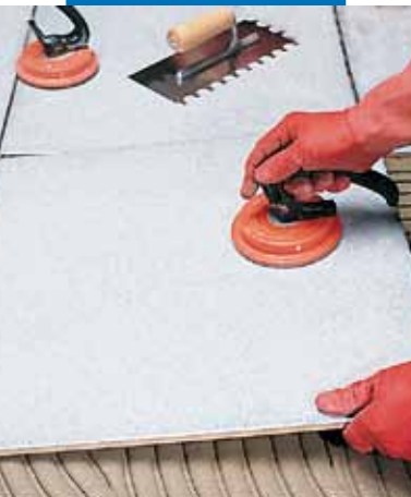
Posa di grande formato
