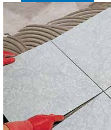
Posa di gres porcellanato
