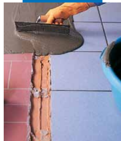
Rasatura di vecchie pavimentazioni con Adesilex P4
