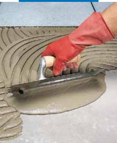
Stesura con spatola a dente semicircolare
