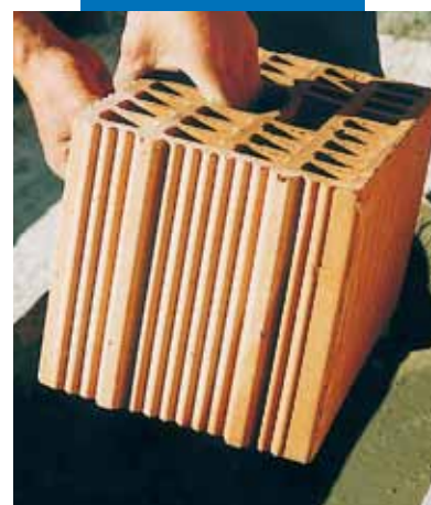
Immersione del blocco in laterizio nell'Adesilex P4
